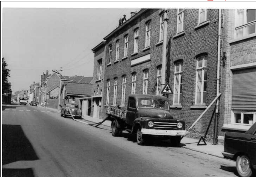
In dit gebouw was de Sint-Aloysiusschool ondergebracht.
