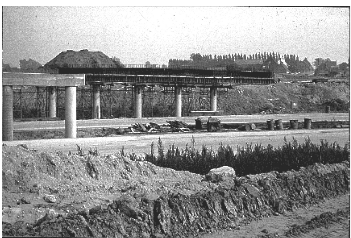
Er wordt druk gewerkt aan de afrit Lichtervelde. Op de foto de brug in aanbouw met De Voerman in de verte.
