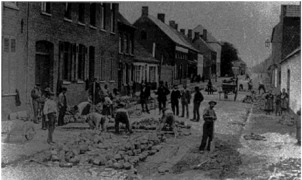
Kasseileggers aan het werk in de Statiestraat, foto genomen ter hoogte van het klooster.
