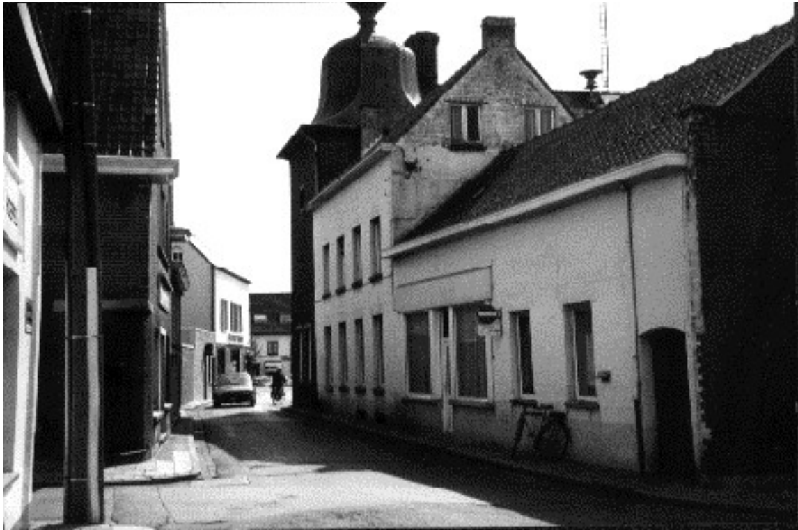
Woonhuis en bakkerij Vancoppenolle na de doortrekking van de Burgemeester Callewaertlaan.
