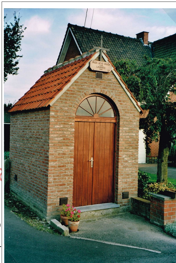
Lesy's kapel na de restauratie in 1995 en vóór de aanrijding in 1998
